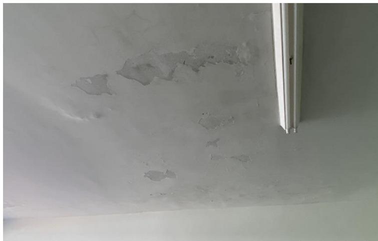
*Marcas de infiltração no teto.*
