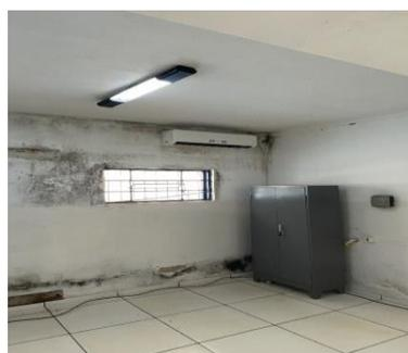
*Paredes com marcas de infiltração e bolor.*
