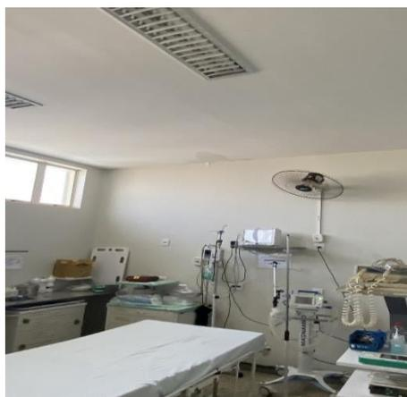
*Marcas de infiltração no teto sobre equipamentos médicos.*
