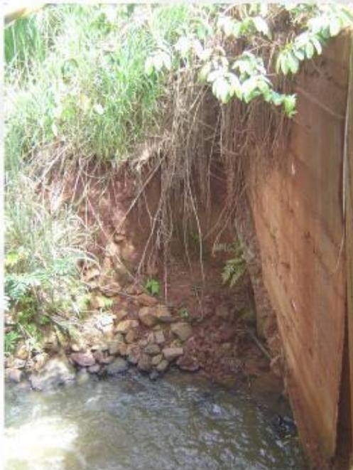
Foto 39: Parte da estrutura de sustentação da travessia levada pela força das águas em função de processos erosivos.
