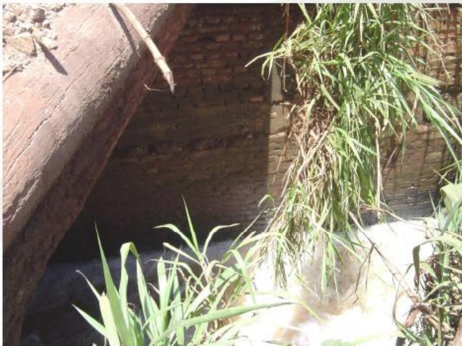
Foto 20: Evidência de processo erosivo na travessia
