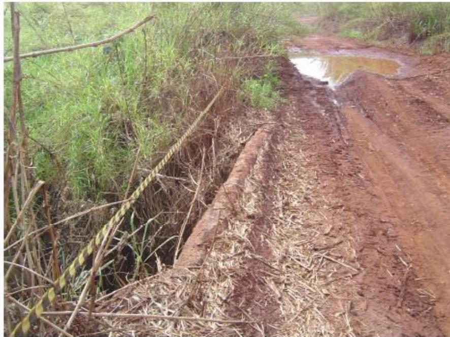
Foto 38: Evidências de processos erosivos nas estruturas de sustentação da travessia
