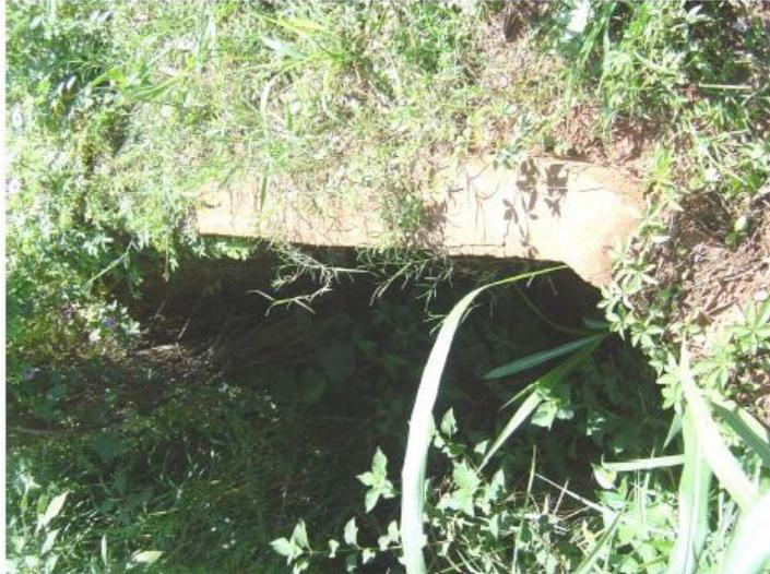
Foto 04: Passagem da água se dá através de tubo de concreto de diâmetro de 1,20 m
