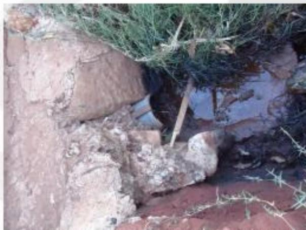
Foto 50 – Saída da boca de lobo 24 – escoamento para canaleta de terra marginal à Rodovia
