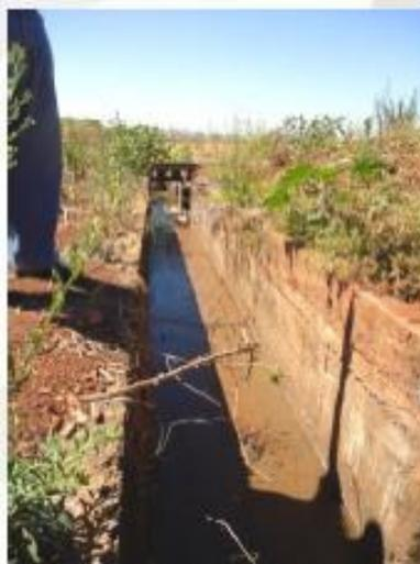
Foto 15 – Saída do Bueiro 04 – Tipo I – Escoamento em Caneta de Concreto.
