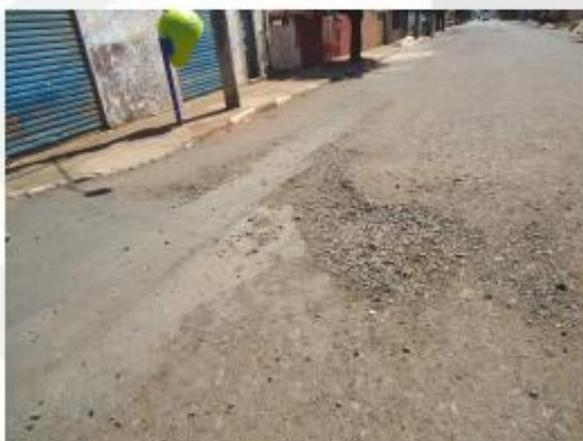
Foto 03 – Rua Benedito Martins – Desgaste do asfalto pelo grande volume de água pluvial que escoam pelo local.
