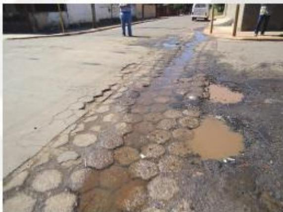
Foto 06 – Cruzamento com as Ruas Benito Martins e Domingos Zacarias- Valeta construída de lajota de concreto sextavado com sinais de desgaste – Ineficiente.
