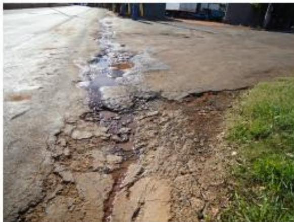
Foto 46 – Saída da boca de lobo 21 – canaleta de concreto armado e parte do asfalto danificada pelo escoamento superficial das águas pluviais.
