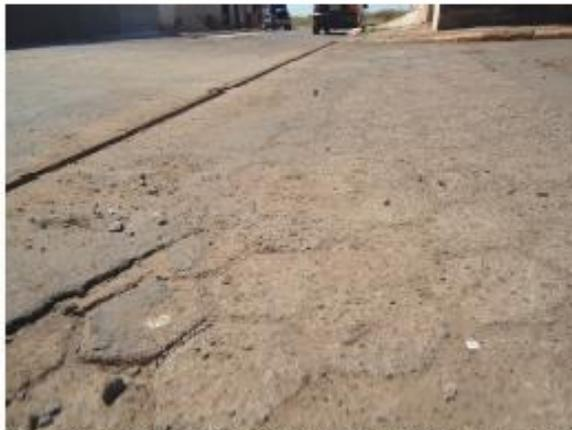
Foto 05 – Cruzamento com as Ruas Benito Martins e Luciano Machado de Campos- Valeta construída de lajota de concreto sextavado com sinais de desgaste.
