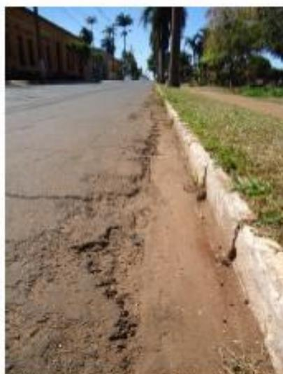
Foto 26 – Rua Bento de Abreu – Asfalto se deteriorando pela passagem da água.
