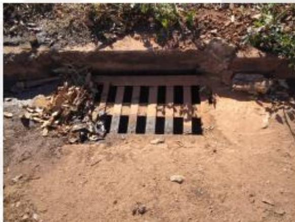
Foto 47 – Boca de lobo 22 – Entrada das águas que escoam superficialmente da boca de lobo
