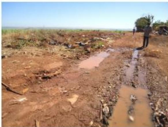
Foto 01 – Cacimbas construídas pela usina como forma de contenção das águas pluviais – Grande quantidade de entulho na área.
