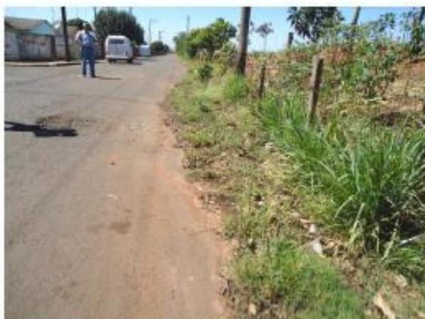
Foto 07 – Cruzamento com as Ruas Benito Martins e Bento de Abreu – Asfalto solapando nas sarjetas e asfalto desgastado.
