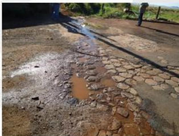
Foto 53 – Canaleta de escoamento de água construído de lajotas de concreto armado. – Água empossada que escoar para área de cana de açúcar.
