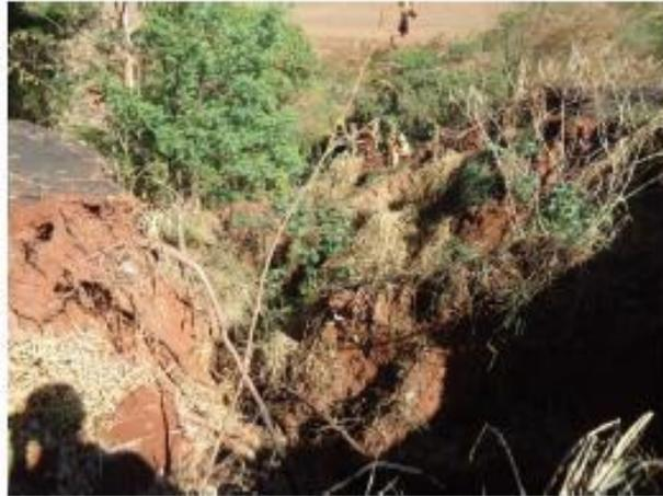
Foto 42 – Desembocadura das águas pluviais – grande processo erosivo ativo próxima a estação de tratamento de esgoto antiga.
