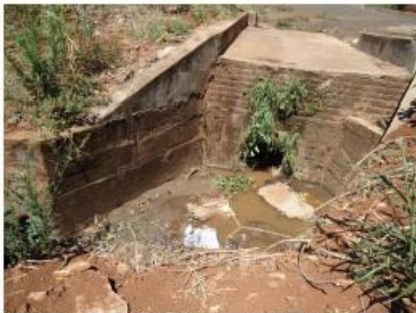
Foto 14 – Saída do Bueiro 04 – Tipo I – Saída da tubulação de 500 mm.
