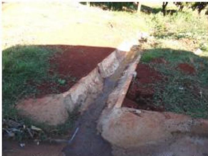
Foto 51– Exemplo das canaletas encontradas na rua marginal à rodovia à SP 257– escoam para a canaleta de terra construída a marginal da rodovia.
