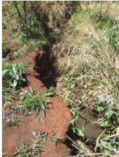
Foto 16 – Saída do Bueiro 04 – Escoamento em canal de terra – Evidências de processo erosivo.
