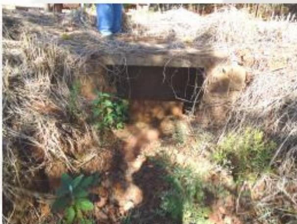
Foto 39 – Entrada da Boca de Lobo 20 que leva parte das águas pluviais a sua descarga
