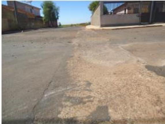
Foto 04 – Cruzamento com as Ruas Benito Martins e Nicola Cirareli - Valeta construída de concreto usinado – Ineficiente.
