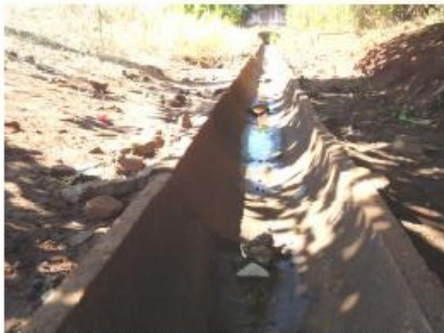
Foto 35 – Detalhe da canaleta de escoamento, saída da boca de lobo 16.
